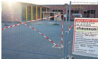
Dans la salle des fêtes, les travaux avancent et les fondations de l'extension en façade ont été coulées. / Photo DDM, D.C.
