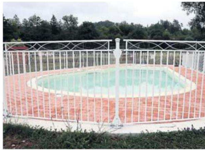
Depuis que le petit bassin a été rénové, il ne peut être ouvert qu'en présence d'un surveillant de baignade.
