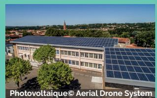
La ville de Carmaux mise sur le solaire en développant des toitures photovoltaïques sur ses bâtiments publics (69 bâtiments pour une puissance totale de 1089kWc). La production annuelle de ces installations a permis de compenser à 47 % la consommation électrique totale de la collectivité et d'éviter 107 tonnes de CO2.!
