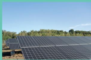
L'ancien bassin houiller du carmausin reconverti au solaire. Sept parcs solaires au sol pour une puissance de 51 MWh et une production annuelle estimée à 64 000 MWh/an, soit l'équivalent des besoins en électricité de 25 000 habitants (hors chauffage).v
