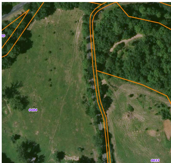
Décalage observé sur la route
