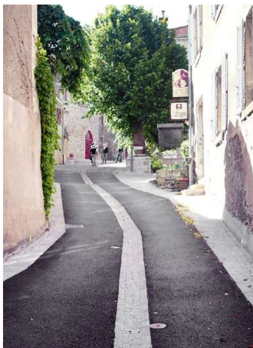
Exemple de réfection de rues permettant de limiter le stationnement sur l'emprise publique (Usson, 63)
