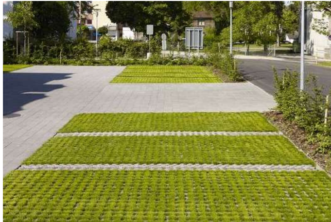
Stationnement enherbé permettant l'infiltration du sol
