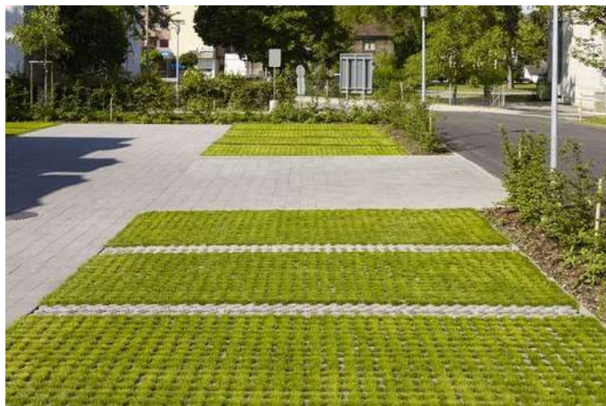
Stationnement enherbé permettant l'infiltration du sol
