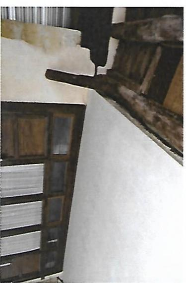
Sous certains couverts, des doublages avec des panneaux de bois sont réalisés (contre-plaqué, OSB, planche de bois...). Ils sont directement fixés à mi-hauteur entre les solives, des quart de ronds assurent leur fixation et la finition. Un isolant peut aussi être intercalé.
