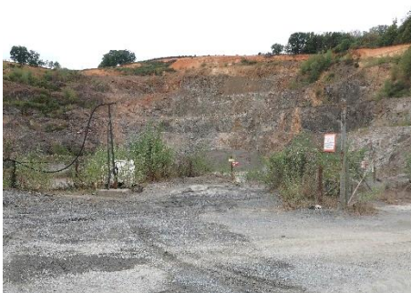
Aire de lavage
