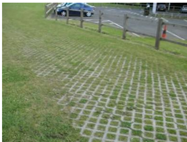
Exemples de revêtements perméables et carrossables
