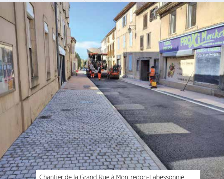
Chantier de la Grand Rue à Montredon-Labessonnié
